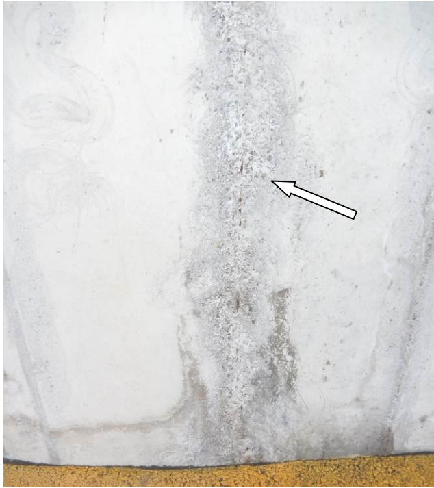
Slika 21: Na površini AB obodne stene uvozne izvozne klančine se na nekaj območjih prisotna mesta delno segregiranega in slabo zalitega betona
