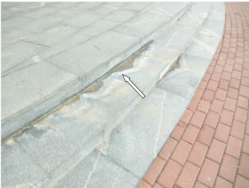
Slika 5: Na finalni oblogi stopnišča, terase in klančine (kamnite plošče) pred vhodom v obravnavani objekt so vidni sledovi vlaženja (beli madeži kot posledica siganja
