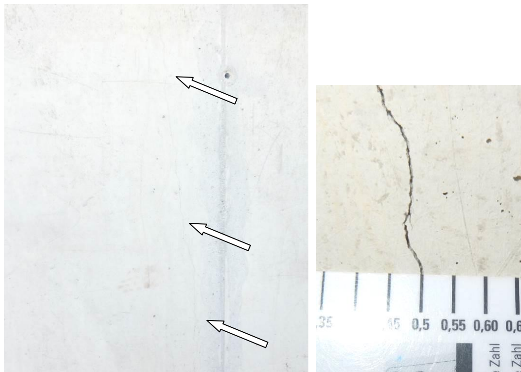
Sliki 16 in 17: Na površini AB obodne stene uvozne izvozne klančine se na nekaj lokacijah pojavljajo razpoke širine do 0,5 mm s vertikalno tendenco poteka
