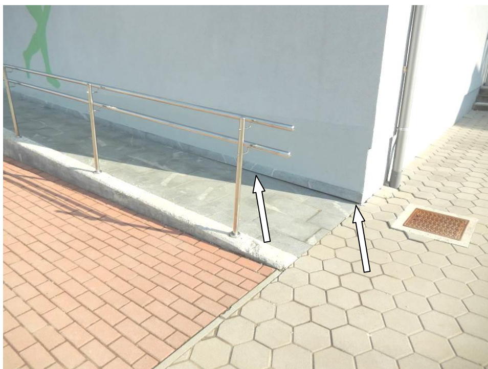
Slika 2: Na JZ strani objekta je na stiku fasadnega podzidka (cokla) in pohodno klančino vidna rega. Obstoječe stopnišče s kamnito finalno oblogo se je posedlo v globino do ca. 2 cm
