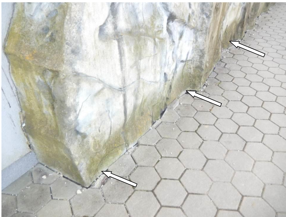
Slika 12: Na SZ strani objekta se na lokaciji stika reliefne fasade (plezalna stena) in betonskih tlakovcev pojavlja rega
