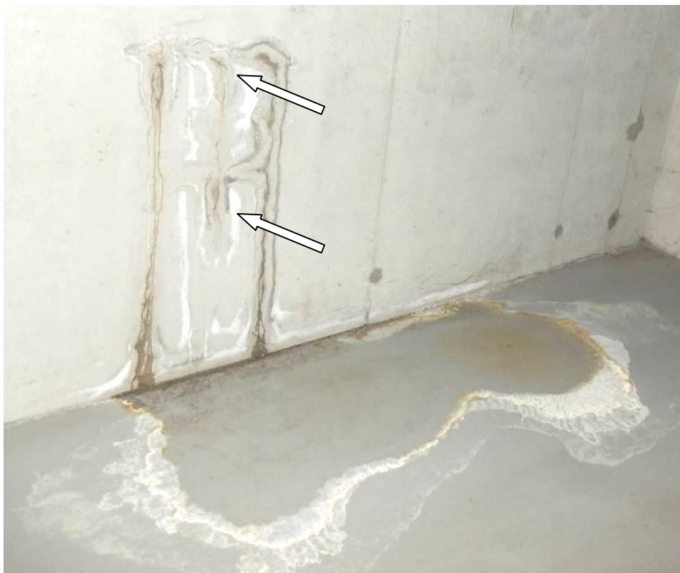
Slika 26: Na površini AB obodne vkopane stene parkirne garaže se mestoma pojavljajo razpoke s vertikalno tendenco poteka. Na teh mestih so vidni tudi sledovi zamakanja (siga) iz razpok
