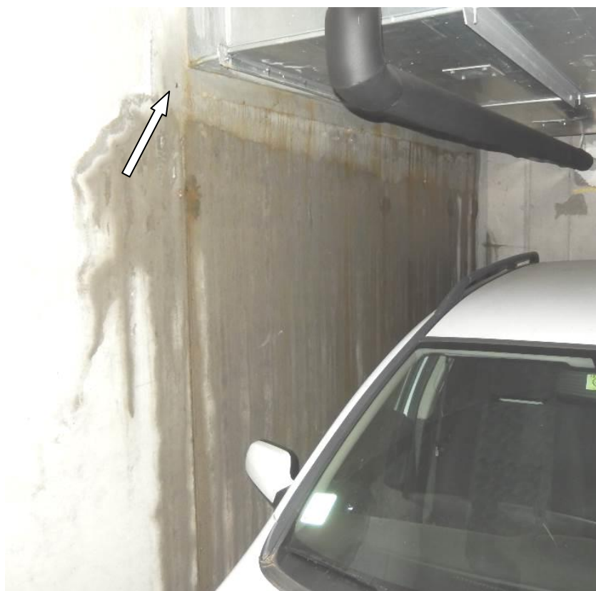
Slika 23: Na obodnih AB stenah na lokaciji preboja pločevinastega požarnega prezračevalnega kanala na skrajni SV stranici objekta je prisotno izrazito zamakanje
