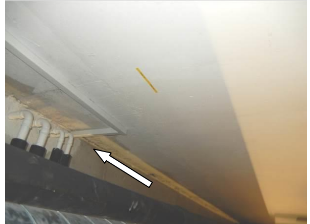
Sliki 39 in 40: Na lokaciji kegljišča na stiku AB obodna vkopana stena in AB plošča na skrajni SV stranici objekta so vidni sledovi zamakanja iz obravnavanega stika
