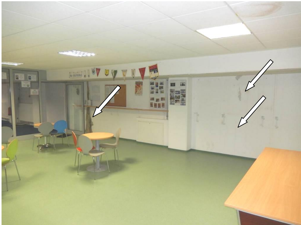
Slika 33: Na površini celotne AB obodne vkopane stene in AB stebrov v prostorih kegljišča so prisotni sledovi zamakanja iz »juvidur« cevi
