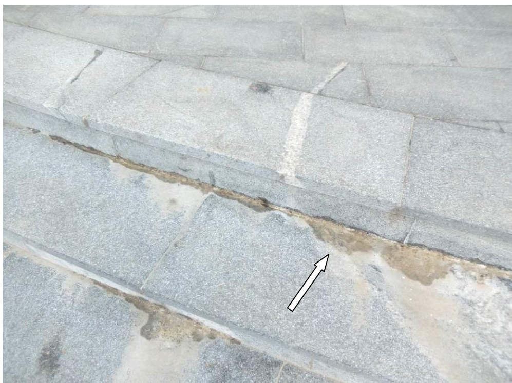
Slika 7: Na lokaciji stopnišča se na stikih med vertikalno in horizontalno finalno oblogo stopnišča (kamnite plošče) pojavljajo izraziti vidni znaki zatekanja in plasti sige
