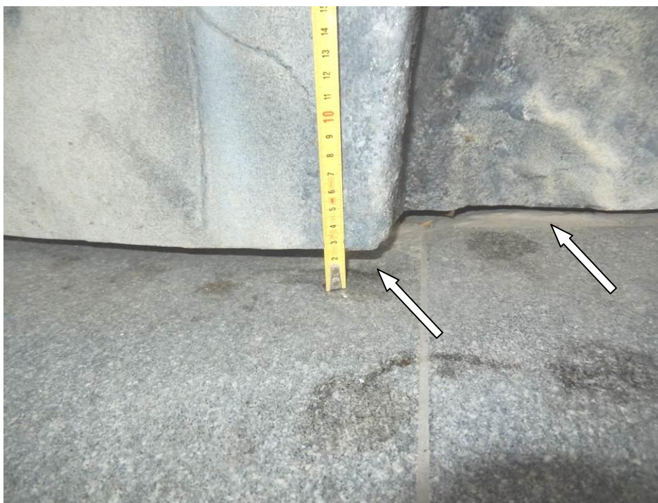
Slika 9: Na stiku finalne obloge terase (zunanji podest) pred vhodom v obravnavani objekt in reliefni fasadi (plezalna stena) je prisotna rega. Obstoječi zunanji podest s kamnito finalno oblogo se je posedel v globino do ca. 2,5 cm
