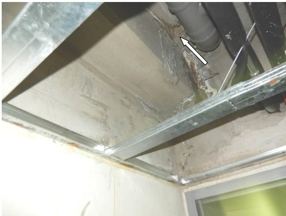
Slika 36: Po celotni liniji stika AB obodna vkopana in AB plošča na skrajni JV in SV stranici objekta so vidni izraziti sledovi zamakanja
