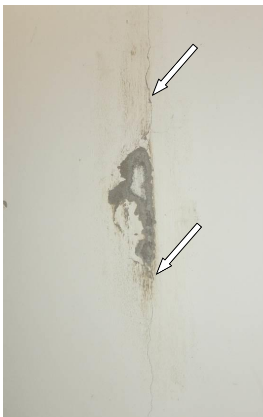
Slika 38: Na površini AB obodne vkopane stene prostorov kegljišča se mestoma pojavljajo razpoke z vertikalno tendenco poteka. Na teh mestih so vidni tudi sledovi zamakanja iz razpok
