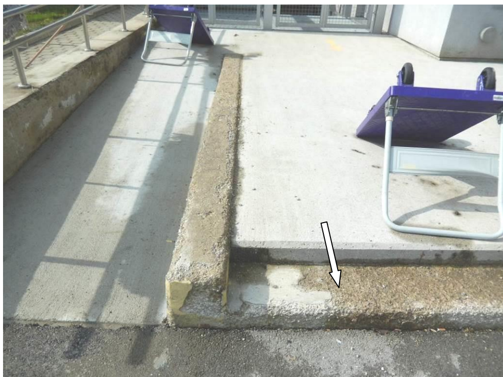
Slika 11: Na vzhodnem vogalu pri prostorih delavnice se na betonskem parapetu in stopnišč pojavljajo sledovi krušenja vrhnjih plasti betona
