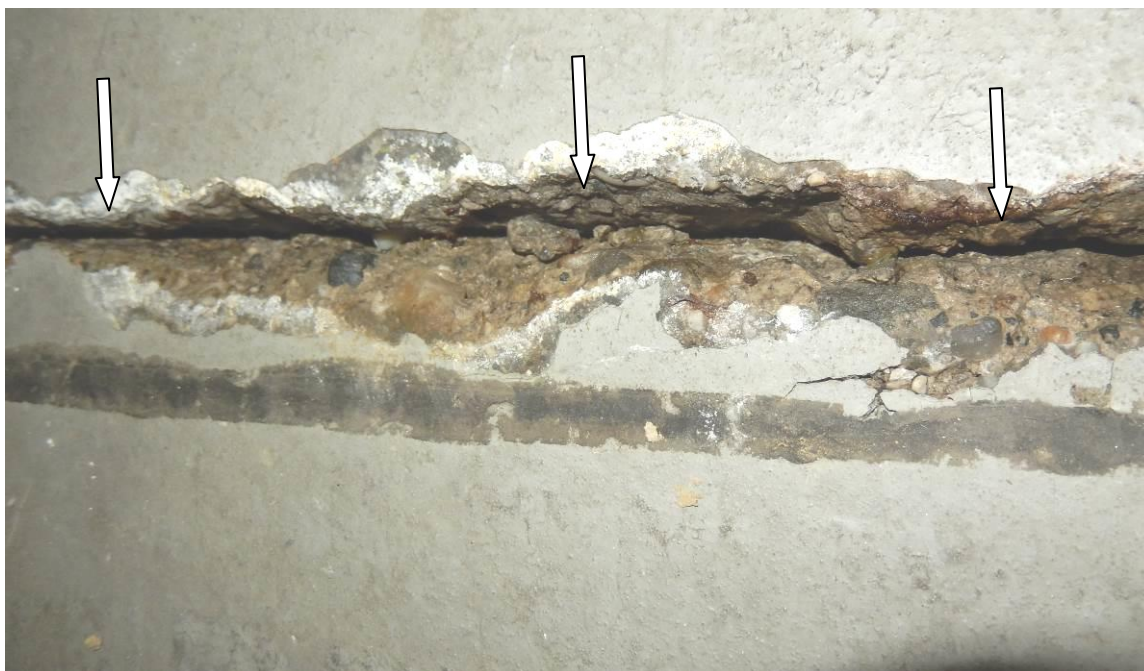
Slika 30: V liniji poteka dilatacije je v AB plošči parkirne garaže kleti je epoksidni premaz odstopil, prisotni so okruški in razpoke v beton ter krušenje zgornjih plasti betona
