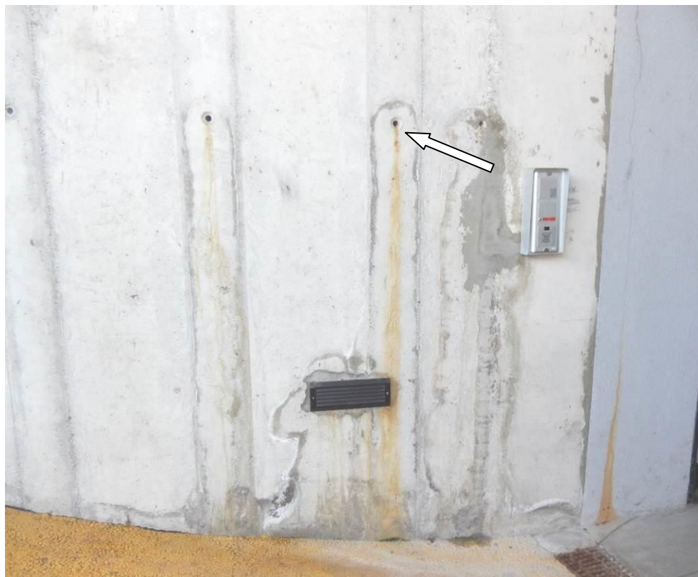
Slika 14: Na površini AB obodne stene uvozne izvozne klančine se pojavljajo sledovi zamakanja iz »juvidur« cevi
