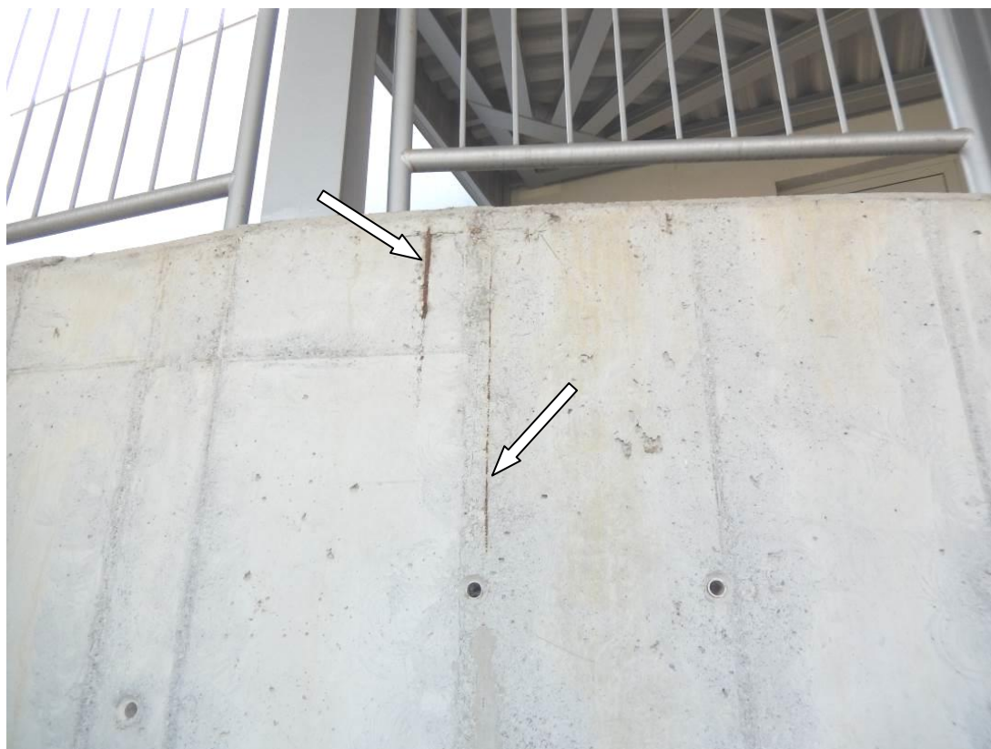
Slika 15: Na površini AB obodne stene uvozne izvozne klančine je mestoma vidna korodirana armatura z minimalno ali brez zaščitnih plasti betona
