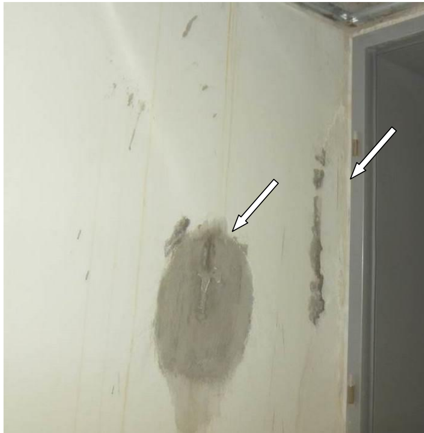
Slika 35: Na površini celotne AB obodne vkopane stene in AB stebrov v prostorih kegljišča so prisotni sledovi zamakanja iz »juvidur« cevi
