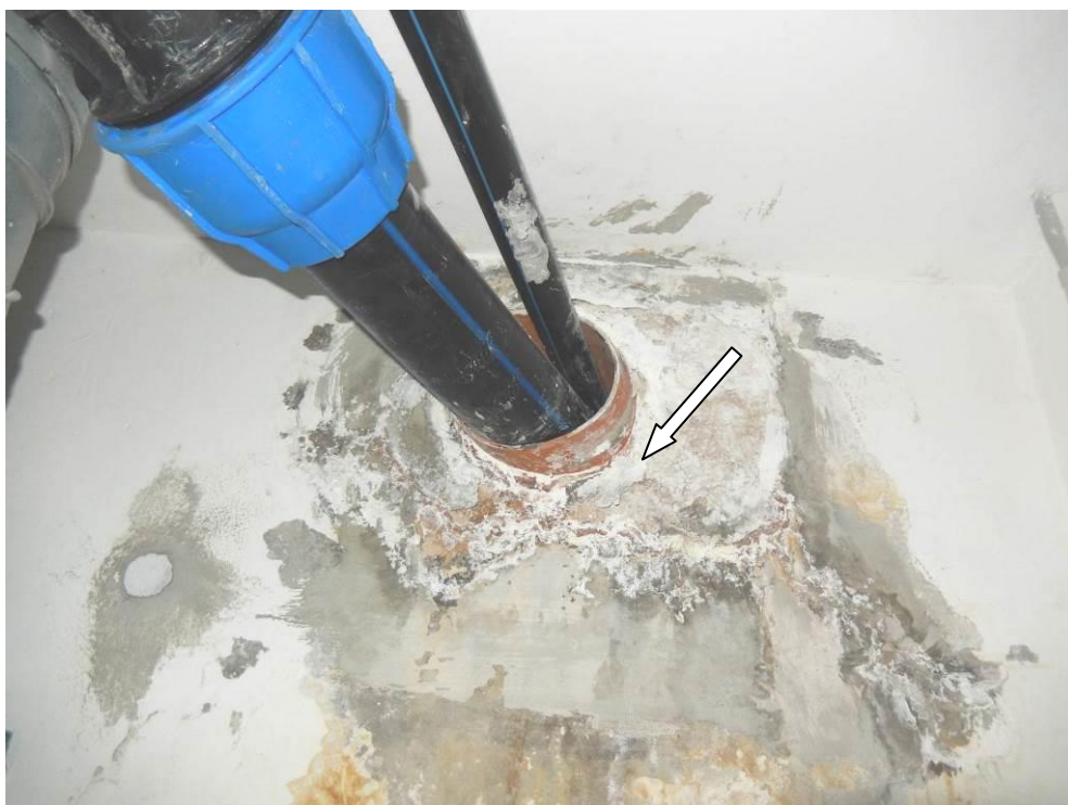
Slika 37: Na lokaciji prebojev na AB obodni vkopani steni na skrajni JV stranici objekta se pojavljajo sledovi zamakanja
