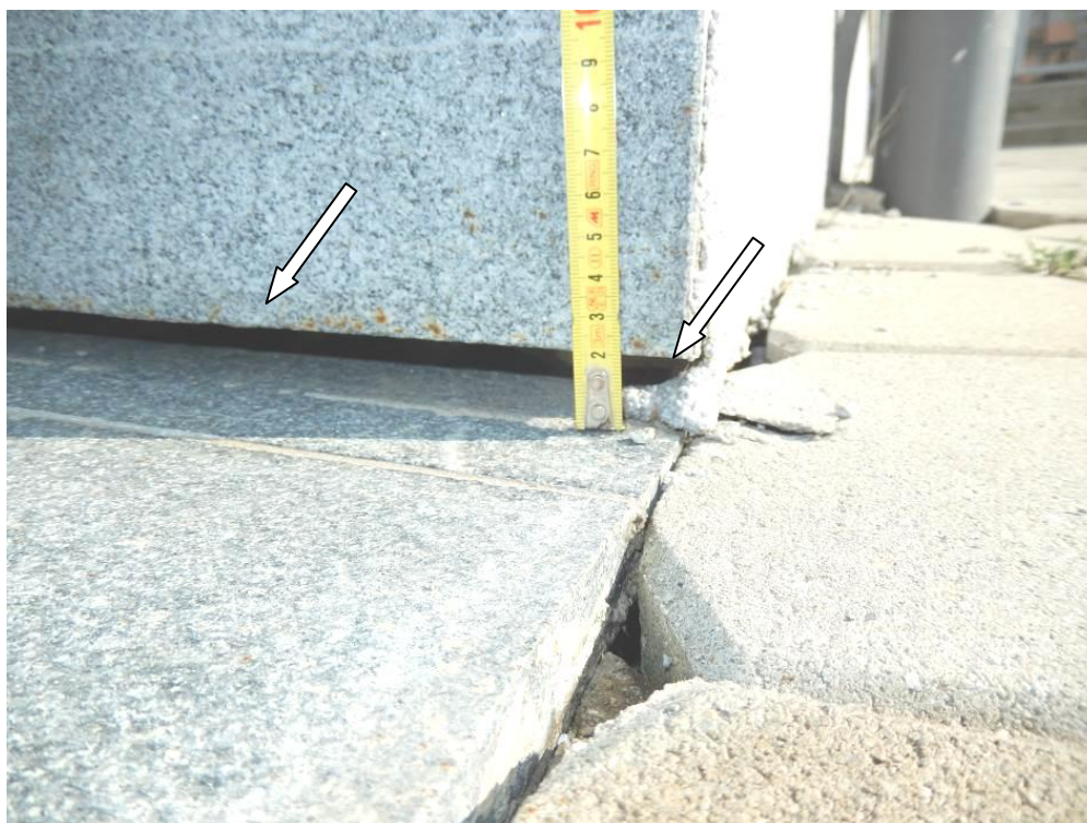
Slika 3: Na JZ strani objekta je na stiku fasadnega podzidka (cokla) in pohodno klančino vidna reza. Obstoječe stopnišče s kamnito finalno oblogo se je posedlo v globino do ca. 2 cm
