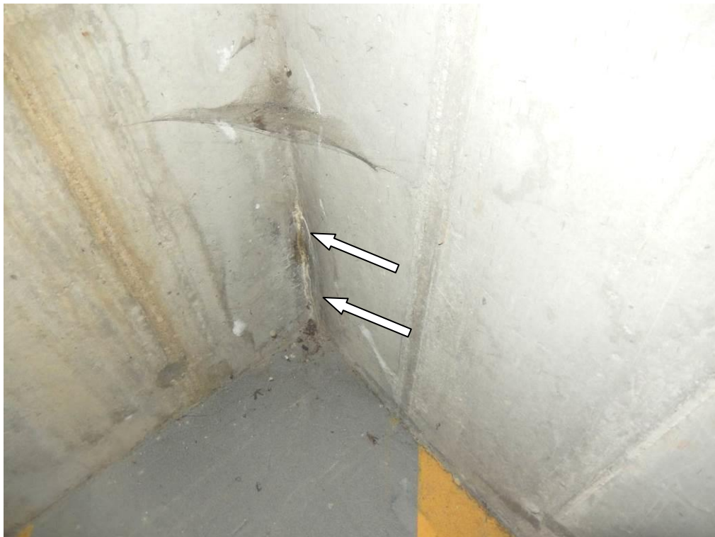
Slika 25: V liniji stikov AB obodna vkopana stena in AB obodna vkopana stena se pojavljajo sledovi zamakanja (siga)
