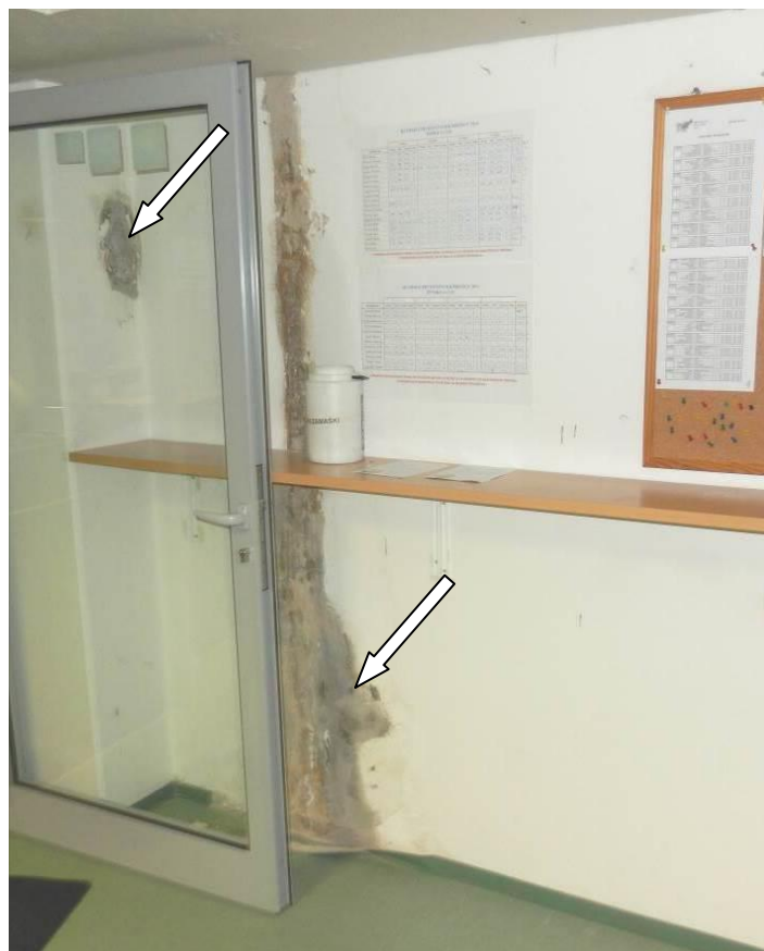
Slika 34: Na površini celotne AB obodne vkopane stene in AB stebrov v prostorih kegljišča so prisotni sledovi zamakanja iz »juvidur« cevi
