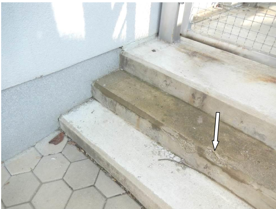
Slika 10: Na JV strani objekta se na betonskih stopnicah, ki vodijo do požarnega stopnišča pojavljajo sledovi krušenja vrhnjih plasti betona
