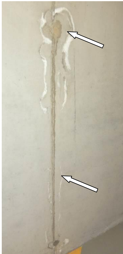
Slika 24: Na AB obodni vkopani steni so vidni sledovi zamakanja iz »juvidur« cevi
